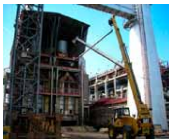
Sl. 11: Reparacija peći u rafineriji nafte
