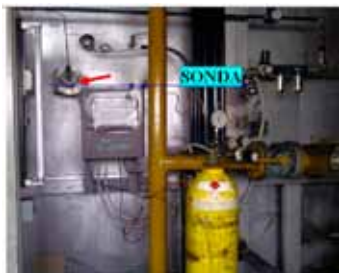
Sl. 13: Sonda za kontrolu atmosfere u peći
