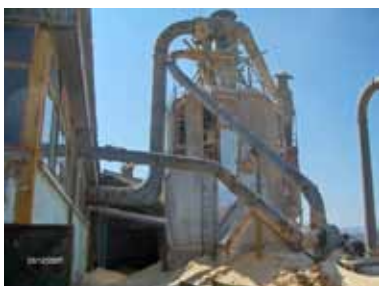
Sl. 3: Drvena piljevina van silosa
