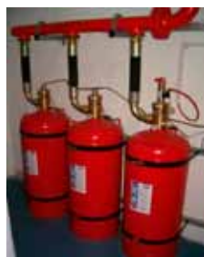
Sl. 12: Automatski sistem za gašenje požara
