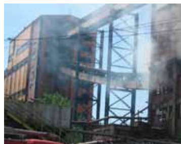
Sl. 6: Požar na transportnim mostovima
